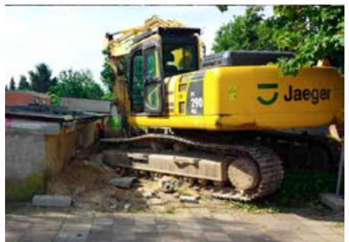
Endlich geht es los! Mit dem Abriss eines alten Schießstandes wird im Juni 2019 Baufreiheit hergestellt
